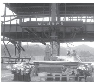
津波に襲われた町の防災対策庁舎
